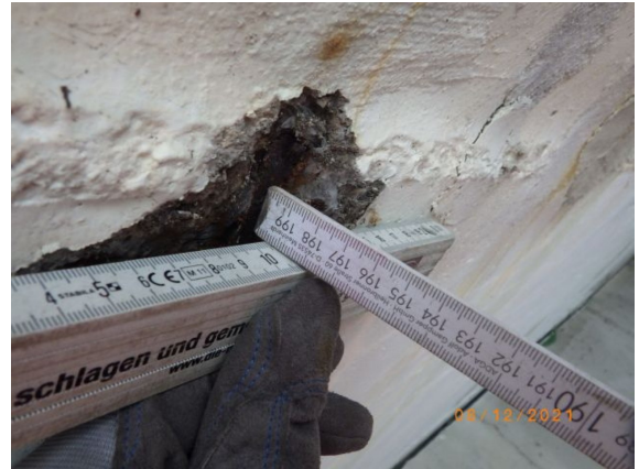
2540507_0_2021E_BETONDECKUNG ZU GERING
