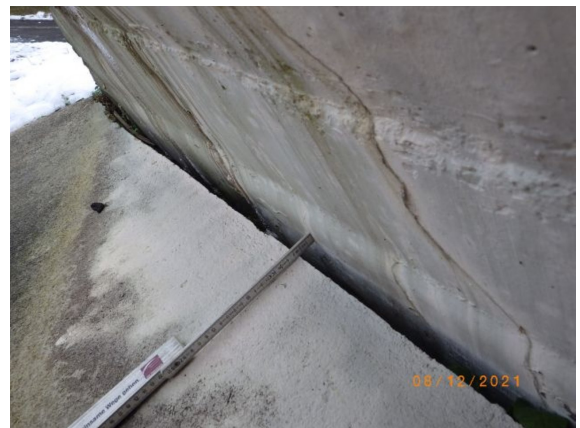
2540507_0_2021E_BEFESTIGTE FLÄCHE VERSCHOBEN RECHTS
