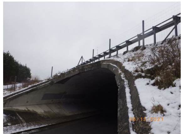
2540507_0_2021E_DISTANZSCHUTZPLANKE FALSCH
