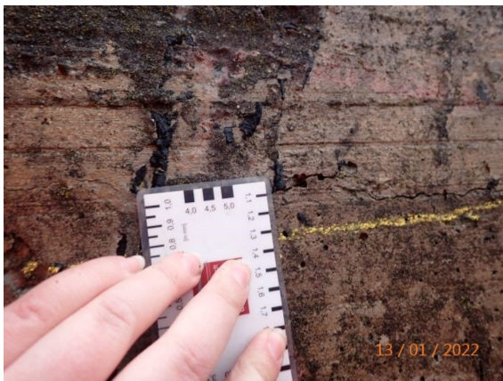
2540507_0_2021E_LINKS LÄNGSRISS STIRNSEITE
