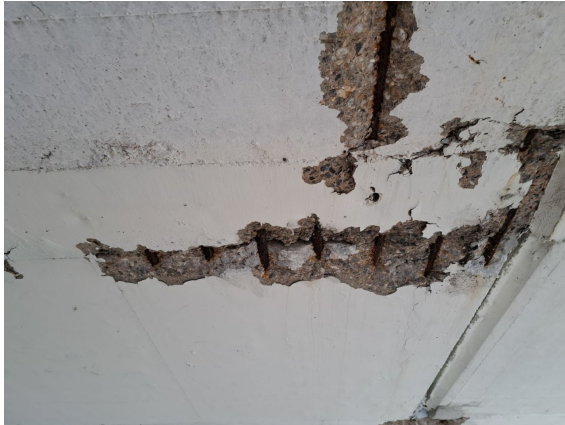
2540507_0_2024H_FREILIEGENDE-BEWEHRUNG
