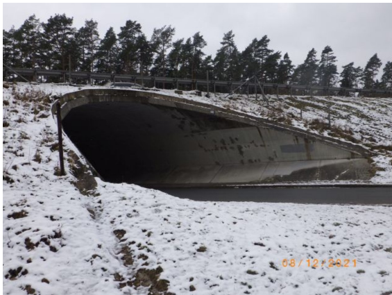
2540507_0_2021E_BÖSCHUNGSTREPPE FEHLT
