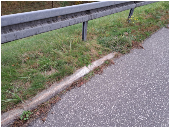
2540507_0_2024H_SCHRAMMBORD-RIFA-BLN-AN PRALLSCHADEN
