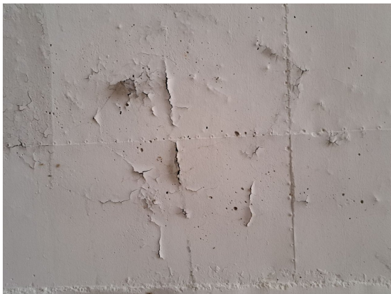
2540507_0_2024H_BESCHICHTUNG-ABGEBLAETTERT
