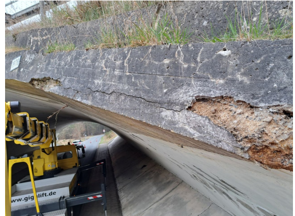
2540507_0_2024H_BOGENSTIRN-RECHTS-ABPLATZUNG
