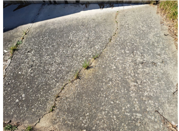
2540507_0_2024H_BOESCHUNGSBEFESTIGUNG-G ERISSEN
