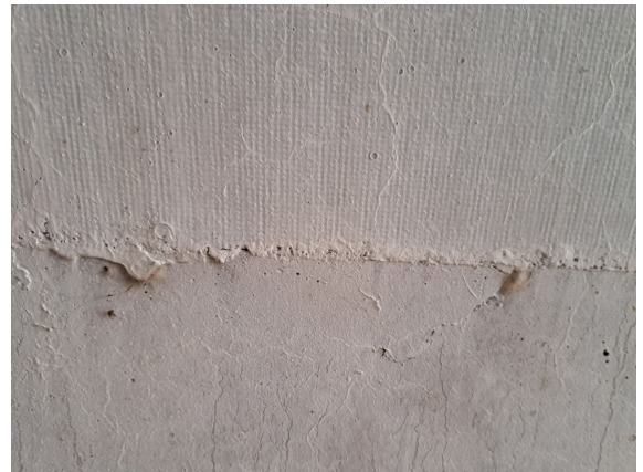
2540507_0_2024H_NETZRISSE-MIT-AUSSINTERUNGEN
