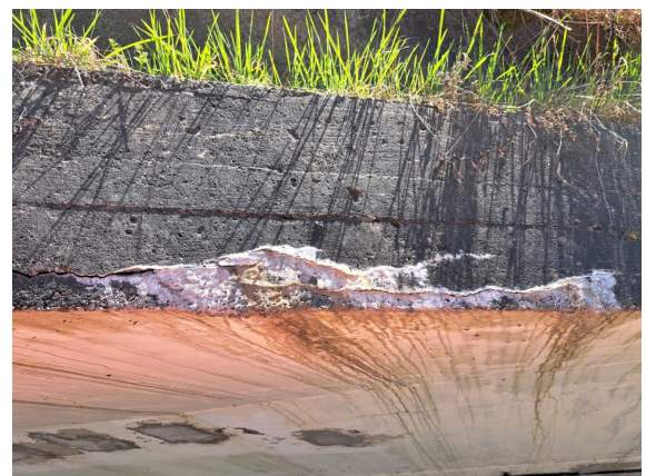
2540507_0_2024H_STIRNWAND-VO-LI-RISS-AUSSINTERUNGEN
