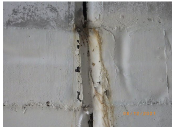
2540507_0_2021E_UNDICHTER STELLE IN FUGE
