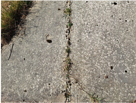
2540507_0_2024H_BOESCHUNGSBEFESTIGUNG-FUGE-BEWACHSEN
