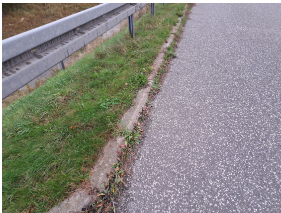
2540507_0_2024H_SCHRAMMBORD-FUGE-BEWACHSEN
